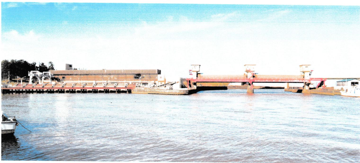
写真は新川河口の水門と排水機場です。右の赤い構造物が新川河口の水門。左の建物が完成当時、東洋一とうたわれた新川河口排水機場です。昭和43年3月に着工し、46年の4月には排水機場が通水し、翌年3月に水門が完成しました。建設された理由は、水溶性ガスの汲み上げによる地盤沈下と昭和39年にあった新潟地震による流域の地盤沈下があります。新川流域はもともと海拔0メートル前後の地域が広がり、機械排水に頼る地域が多くありました。このため排水量の増加や潮位の上昇により自然排水が出来なくなると、水門を閉じて日本海への機械排水となります。この新川河口排水機場のあるおかげで、旧西蒲原地域の排水がコントロールされています。
