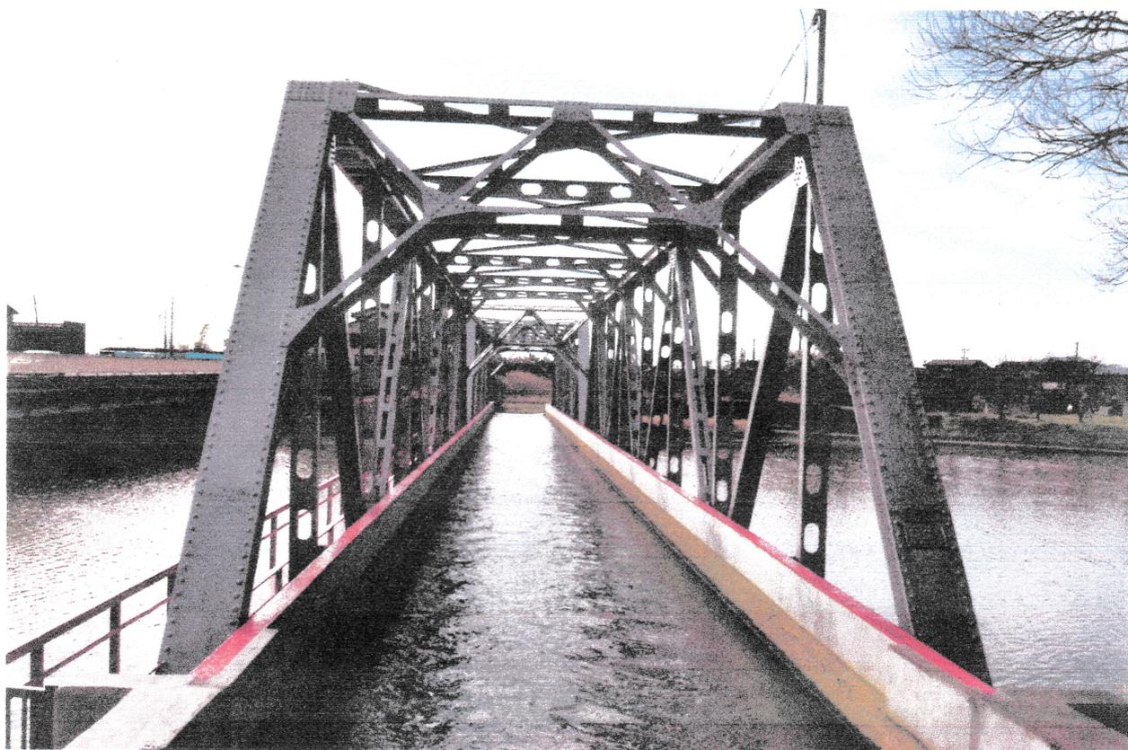
写真は内野にある新川と西川の立体交差、西川の水路橋です。水路橋の下を流れるのが江戸時代の文化、文政年間に開削された新川です。上を流れる西川は大河津分水で信濃川から取水し、旧西蒲原地域の農地を潤し、再び平島で信濃川に合流します。西川は農業用水として、地域の重要な役割を担っています。水量も農繁期と農閑期では大きく変わります。
